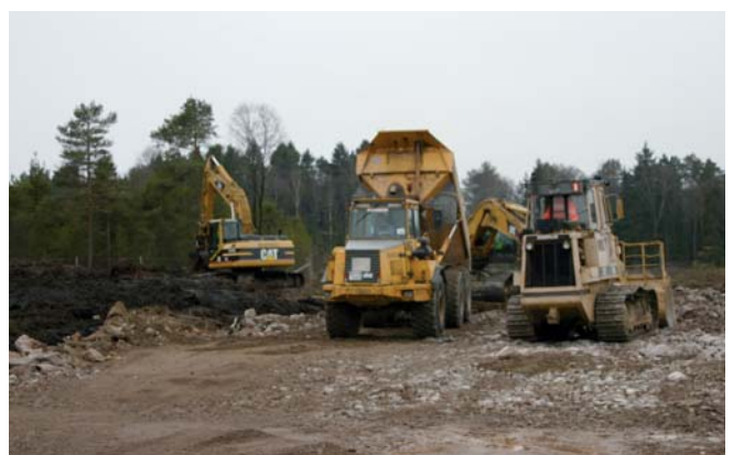
Arbete med ny väg genom området.
