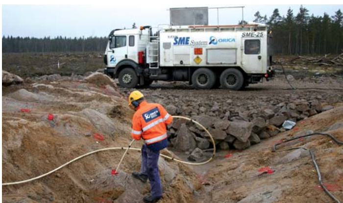
Sprängämne fylls på som en förberedelse i att spränga berg.
