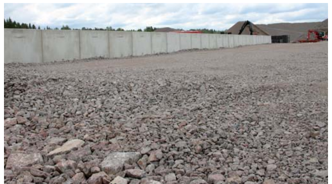
Den första behandlingsytan tas i bruk efter semestern. Här ska avfall mellanlagras och behandlas. I bakgrunden syns stödmurar.
