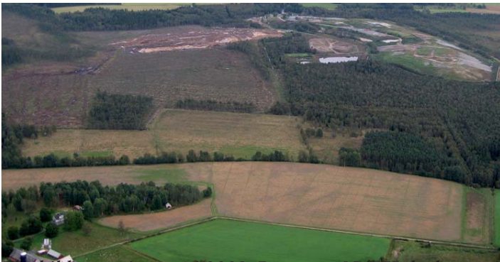
Flygbild tagen i augusti 2008. Bygget av Nya Hult ska precis starta.
