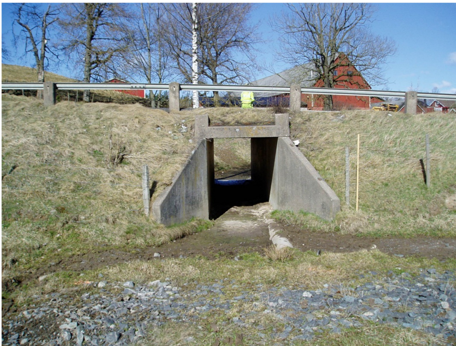
Bild på befintlig kopassage
