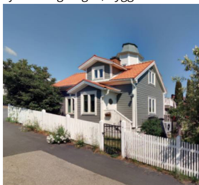
Byggnad Tranan 8 mot Krönleinstigen, byggår 1909
