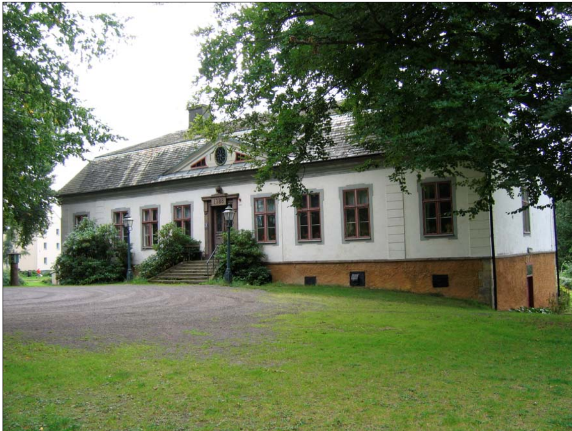
Huvudbyggnadens fasad mot gården med huvudingången. Foto 2005.
