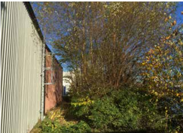
Jönköping Energis byggnad som används som kylcentral
