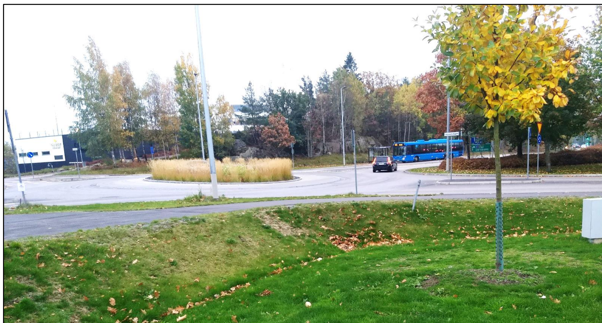
Figur 18. Exempel på svackdike.
