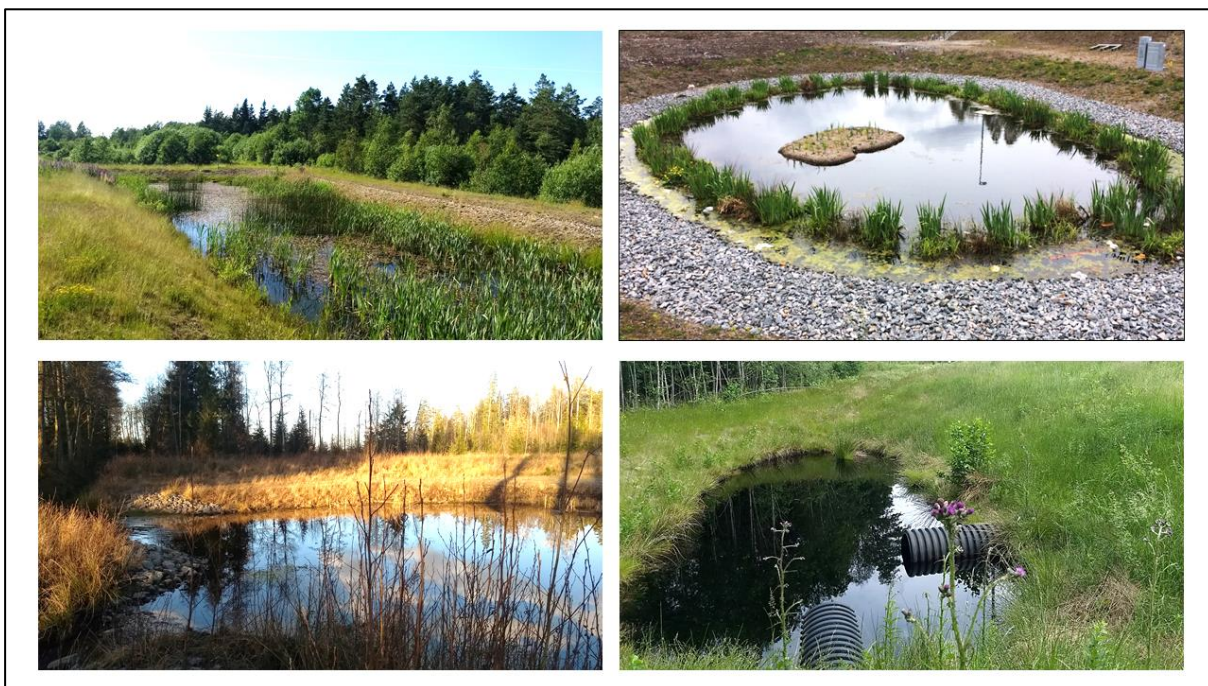
Figur 17. Exempel på dagvattendammar.
