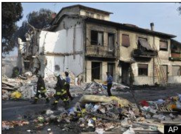
Figur 16. Skadade byggnader Viareggio.
