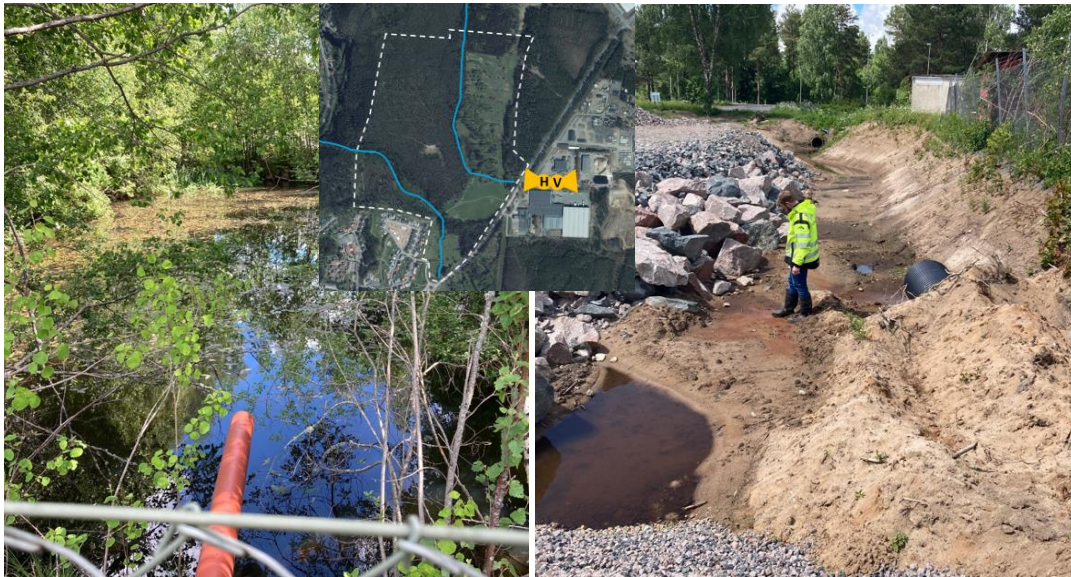
Figur 5: Vänster bild visar fördröjningsdamm för industriområde och bilskrot uppströms utredningsområdet. Höger bild visar markberedning mellan befintlig damm och Tahevägen.
