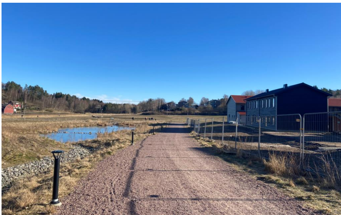
Figur 28: Dagvattendamm och krossdiken för nytt bostadsområde i Ytterby, kungälv kommun. Bild tagen 2023-03-05.
