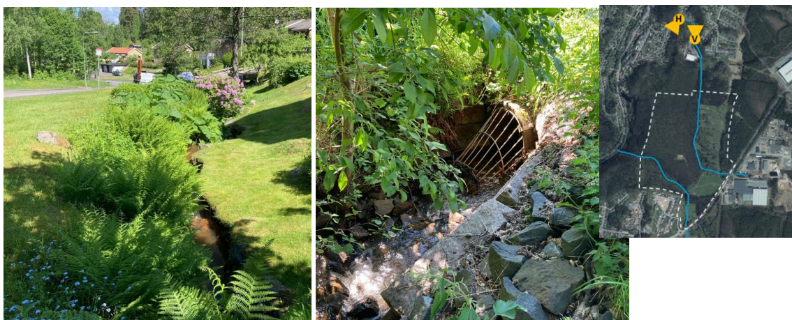
Figur 3: Vänster bild visar att vattnet lämnar utredningsområdet i norr och rinner vidare i bäcken vid ett villaområde och ner under marken genom ett galler enligt höger bild.
