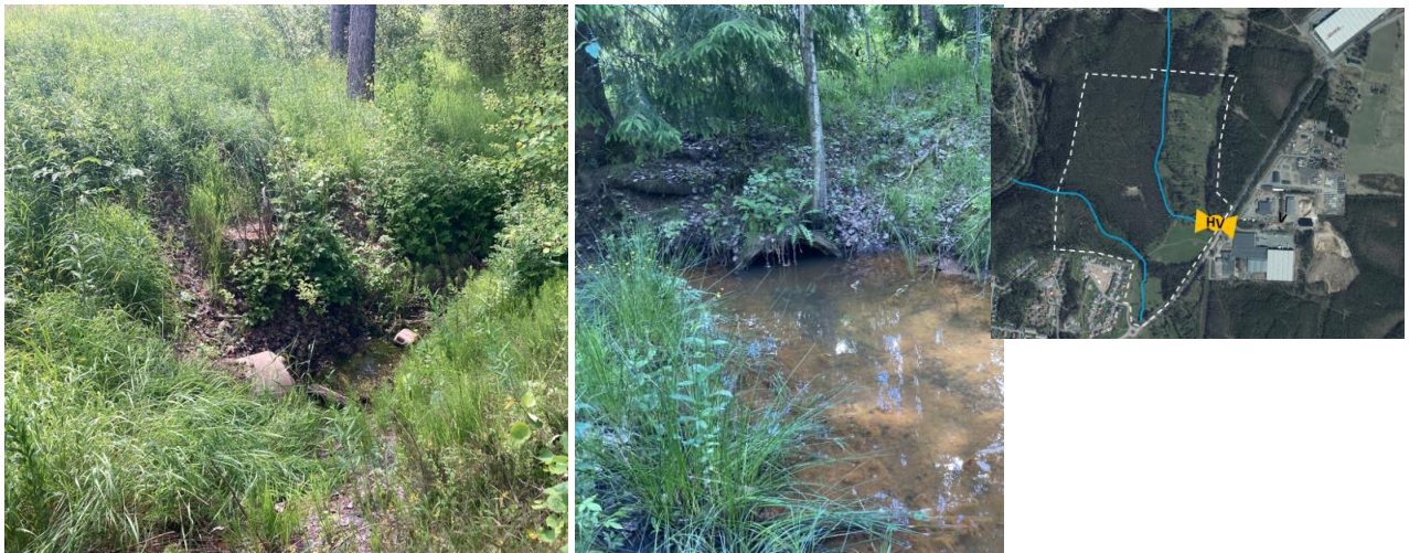
Figur 6: Vänster bild visar utlopp från industriområdet in till utredningsområdet genom trumma i betong. Höger bild visar karaktären av östra bäcken i början av vattnets avrinning genom utredningsområdet.
