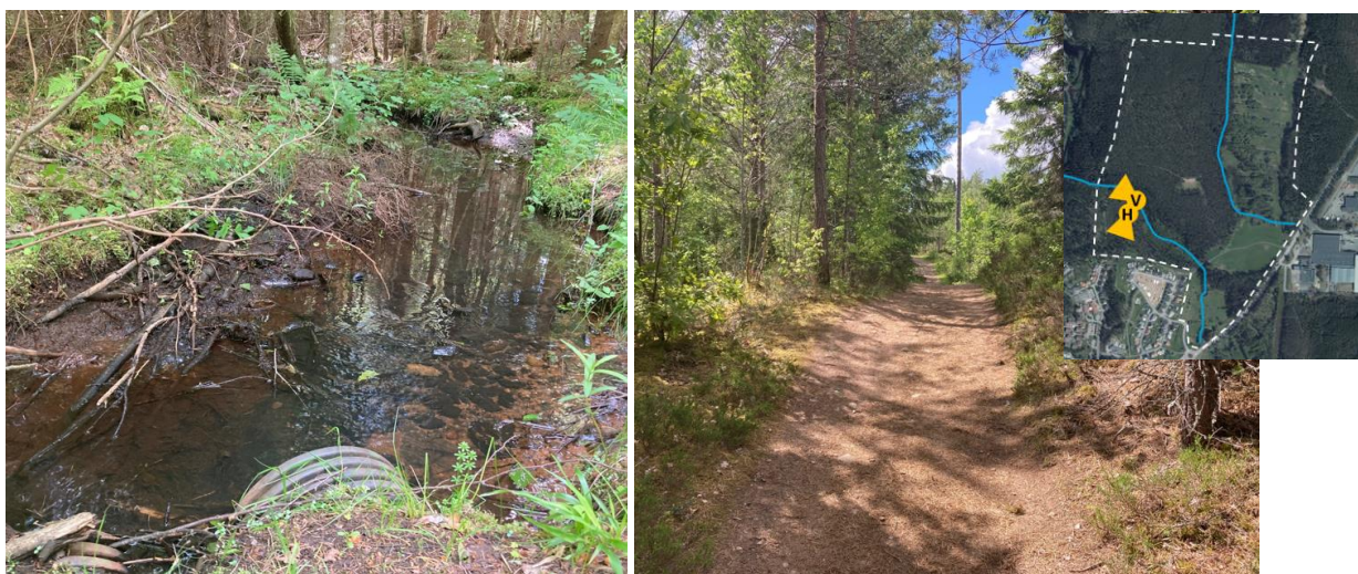
Figur 11: Vänster bild visar västra bäckens karaktär när vattnet lämnar utredningsområdet. Vattnet rinner under en gångväg genom en trumma i PVC. Höger bild visar gångväg inom skogsmark.
