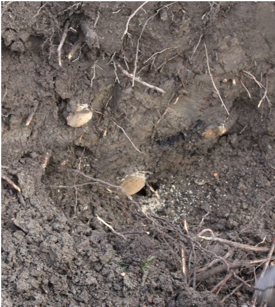
Figur 4. Korrekt beskurna rötter vid schakt.
