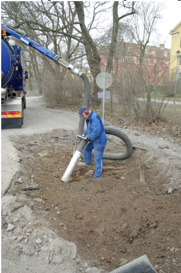
Figur 2. Rotkartering med vakuumschakt.
