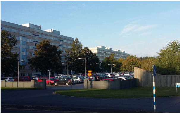
Befintlig markparkering med garage under.
