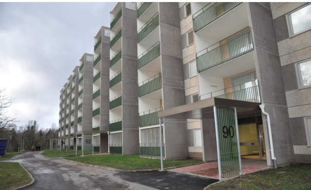
Exempel på nyare fasadrenoveringar
