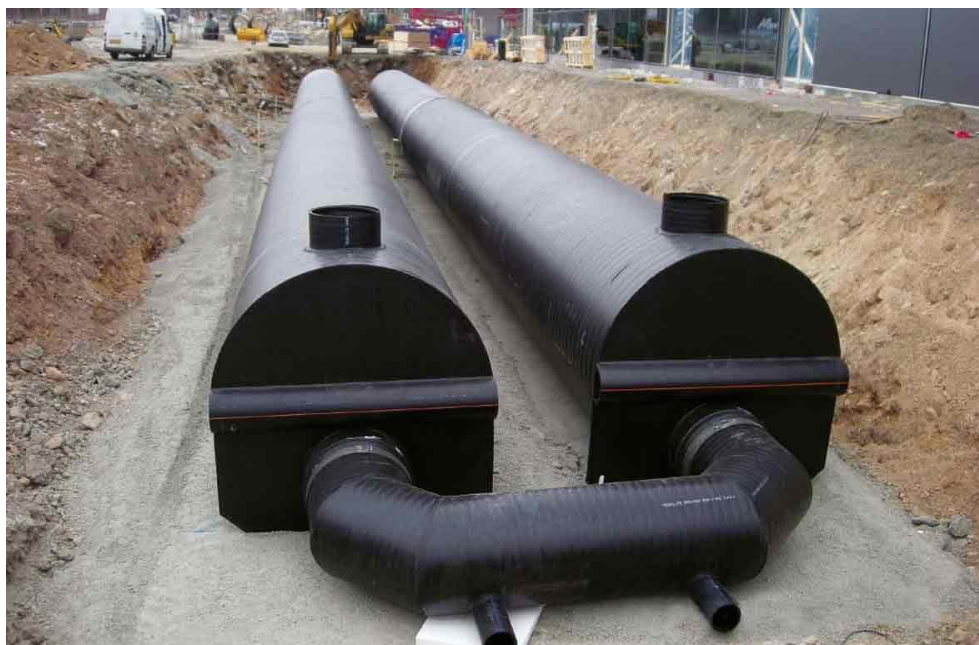
Figur 20. Fotografi i sektion på ett rörmagasin bestående av två rör (Uponor, 2023)
