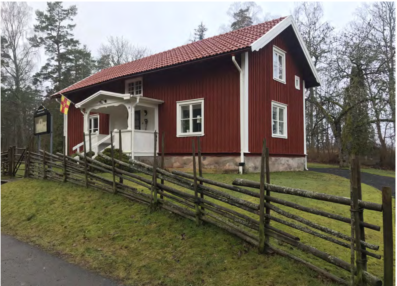
Befintlig byggnad på Flahult 2:343
