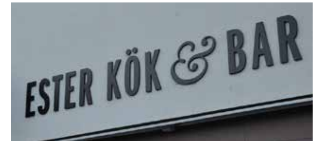
Friliggande bokstäver på fasad
