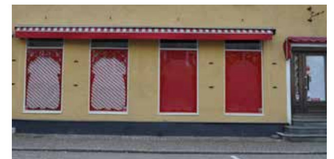
Om butiker har stängt under längre perioder bör skyltfönstren användas för t.ex. annan lokal marknadsföring eller konst.
