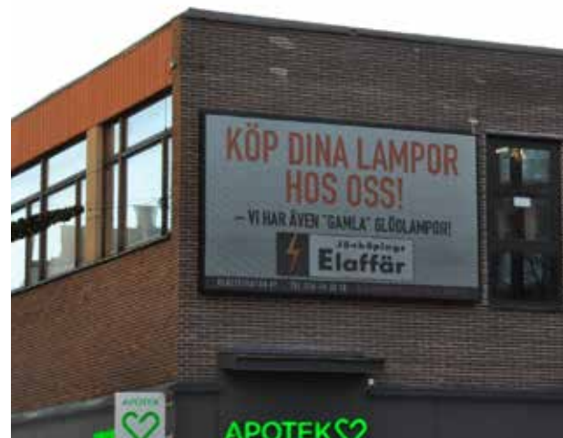
LED-skylltar kräver bygglov
