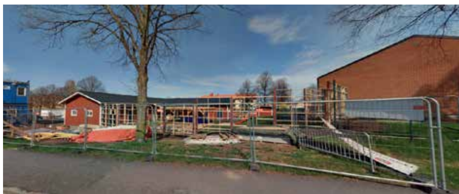
Bild 16. Förskolan förses med ett bullerskydd i Maj 2018. Buller skydd planeras även på andra ställen. Buller skydd behövs för att hindra skadligt buller från stadsgator, järnväg och E4 som ligger nära Rosenlundsskolan.
