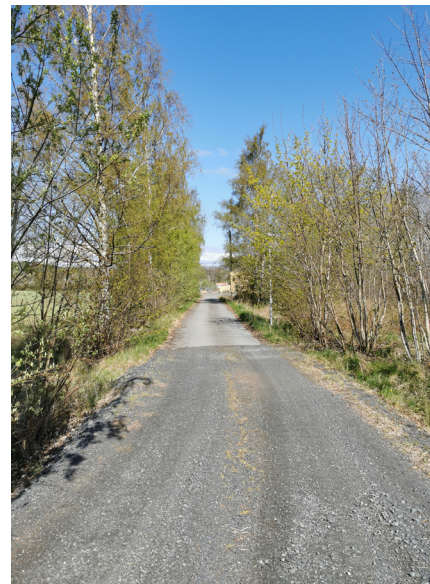
Figur 4. Befintlig väg till panncentralen med björkallé
