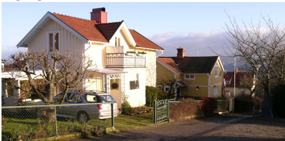
Figur 5 Byggnaderna på Tranan 11 och 12 sett från Krönleinstigen.
