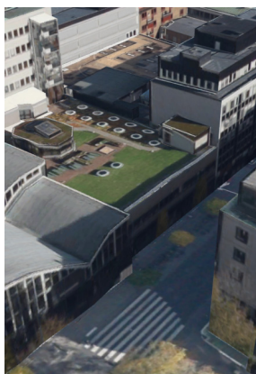
Mot Västra Storgatan
