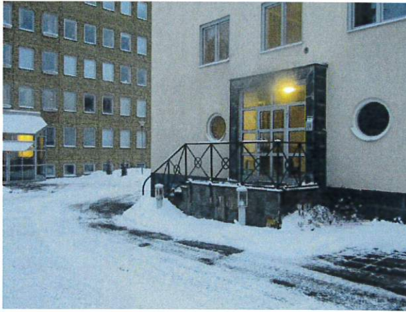
Den äldre byggnadens entréparti.
