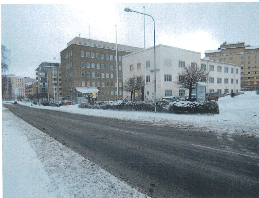
Den äldre, putsade kontorsbyggnaden och den yngre med tegelfasad.
