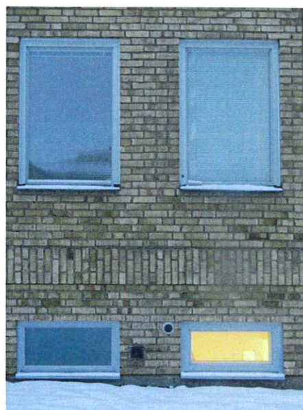
Detalj av den yngre byggnadens tegelmurning i mönster.
