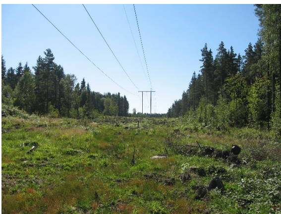
Figur 4. Foto över ledningsgatan i etapp 2. Foto taget mot söder (källa Sigma Civil AB)
