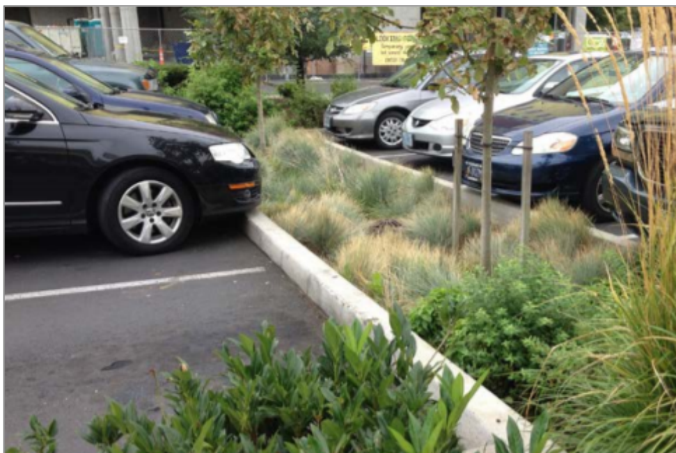
Figur 5-3. Exempelbild på en nedsänkt växtbädd intill en parkering (Stockholm Vatten och Avfall, 2019).
