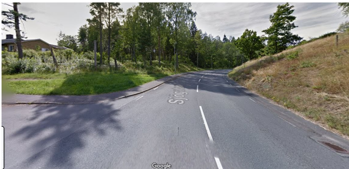
Från NO i korsningen Sjögatan/Löjtnantsvägen
