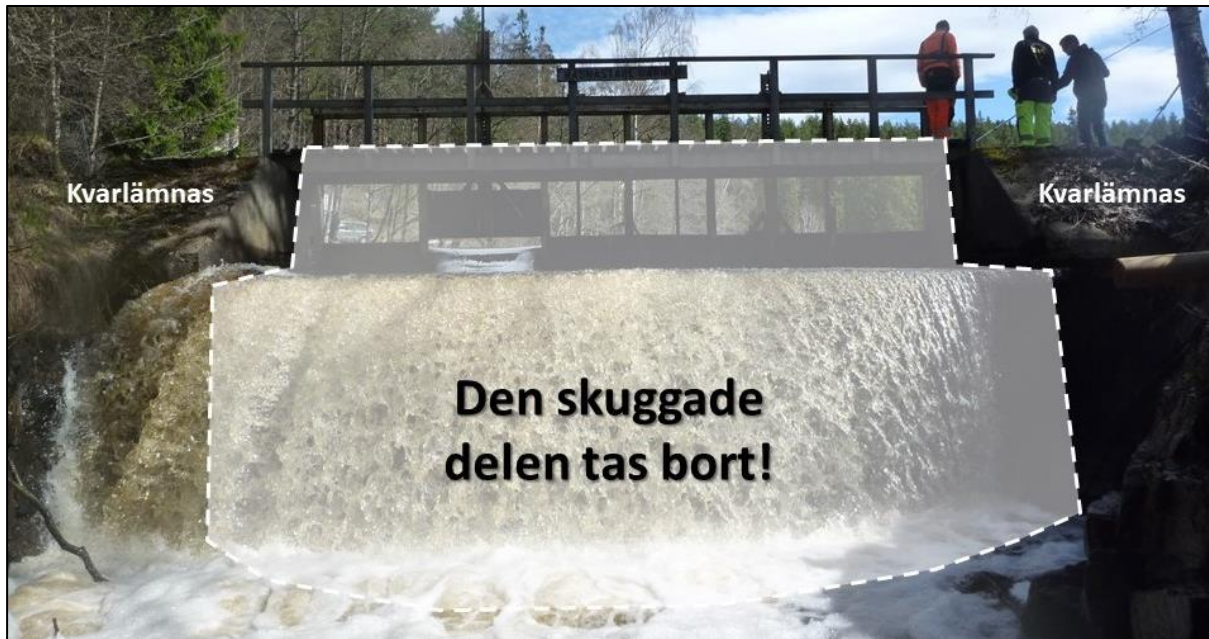
Figur 5. Planerad utformning av utrivningen av Masmästardammen i Tabergsån.
