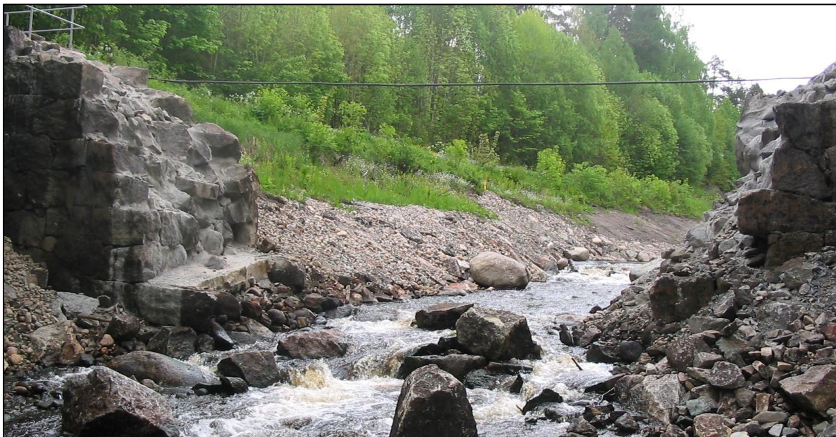
Figur 6. Hökhultsdammen i Tabergsån efter utrivningen 2005.
