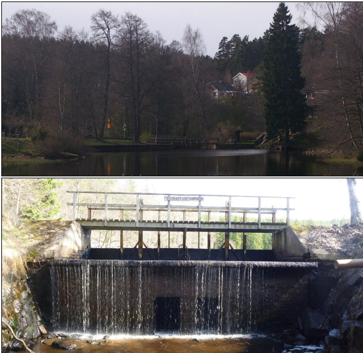
Figur 2. Masmästardammen och del av indämningen uppströms dammen (överst) respektive nedströmssidan av dammen (nederst) (foto: Jönköpings Fiskeribiologi AB).
