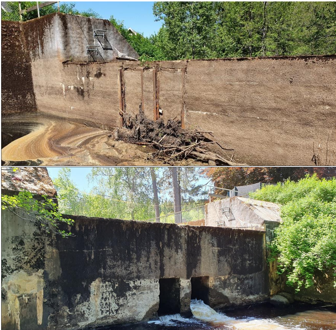
Figur 3. Magnussonadammen sedd från uppströmssidan (överst) respektive nedströmssidan (nederst) i samband med inmätningen 2020-06-03 (foto: Jönköpings Fiskeribiologi AB).
