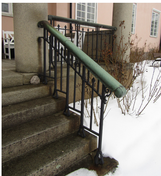
Äldre byggnadsdetaljer på huvudbyggnaden.
