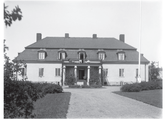
Foto från 1936. Notera de ursprungliga entréportarna med överljus. I rundeln framför entrén ses den gjutjärnsurna som prydde trädgården fram till den stals för några år sedan. Foto: Jönköpings läns museum.
