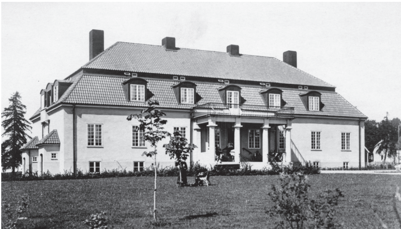
Odaterat fotot av sjukhemmets byggnad. De tämligen nyplanterade träden tyder på att fotot är taget vid mitten av 1920-talet. Vid den västra gaveln ses de två ingångarna till tvättstugan respektive det nordvästra trapphuset. Foto: Jönköpings läns museum.
