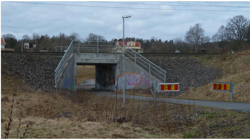
I norr finns en port för gc-traffic under järnvägen.
