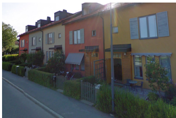
Exempel på radhus med mindre förgård utmed huvudgatorna. Kälvestavägen, Solhem.
