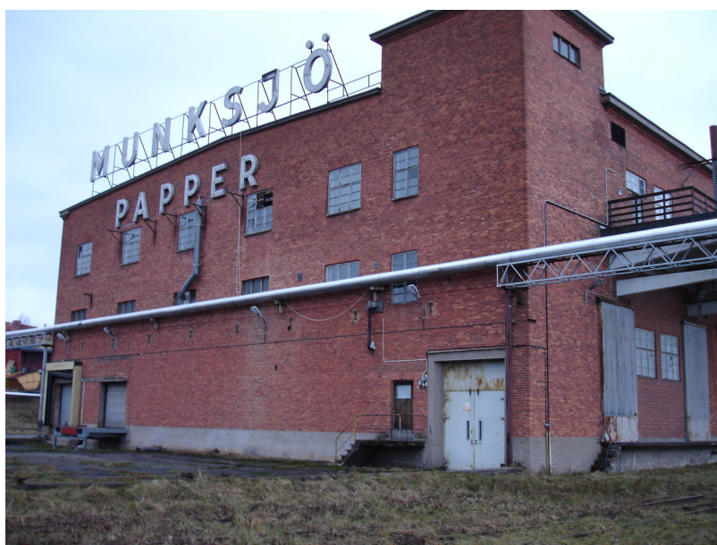
Byggnad 134, vy från sydost.
