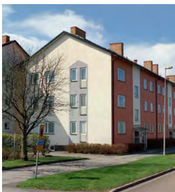
Figur 20. Foto på kulturhistorisk värdefull byggnad på fastigheten Växjö 16, sydöst om planområde.
