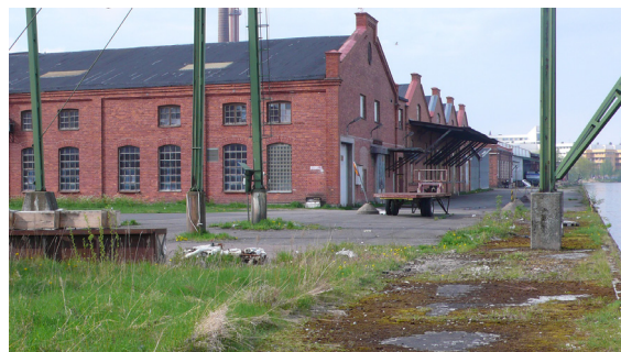
Gavlar längs kaj - hus 33b
