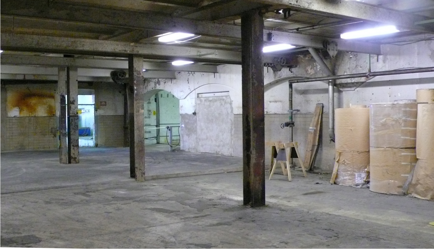
1 Interiör hus 11. 2 Järnbalksförbindningar för Holländeriet 1913. Källa: Munksjö pappersbruks ritningsarkiv 3 Fasaddetalj av västra gaveln på Valsbotten 11.
