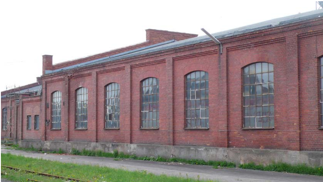
1 Papperssalen 19 – fasad mot öster och interiör. 2 Interiör 3 Fasad
