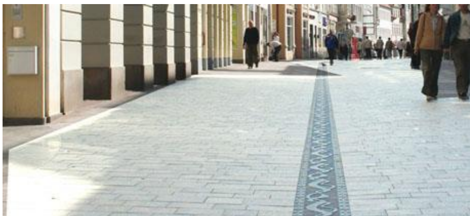
Figur 11. Exempel på linjeavvattning, bild hämtad från http://acodrain.se/va/linjeavvattning/ 18-10-20
