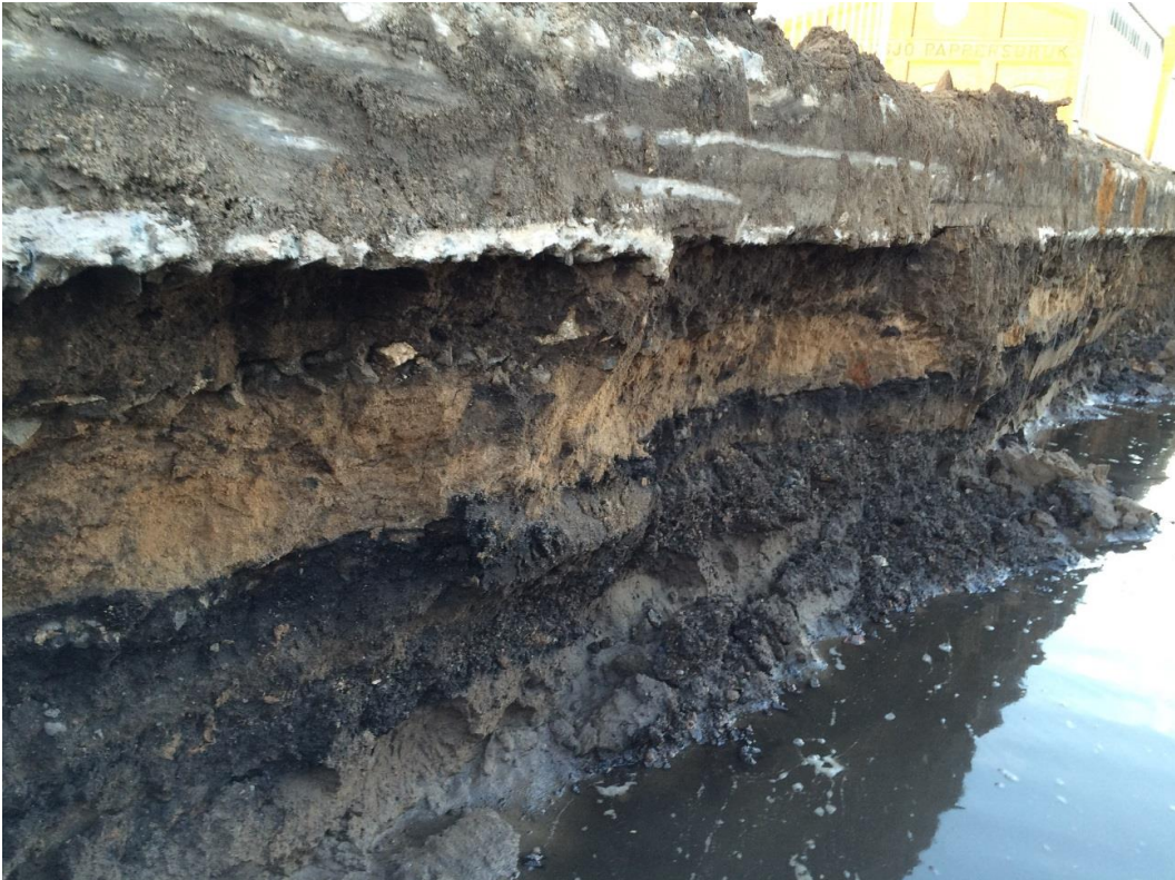
Del av schaktvägg 13M-16M med betongplatta.
