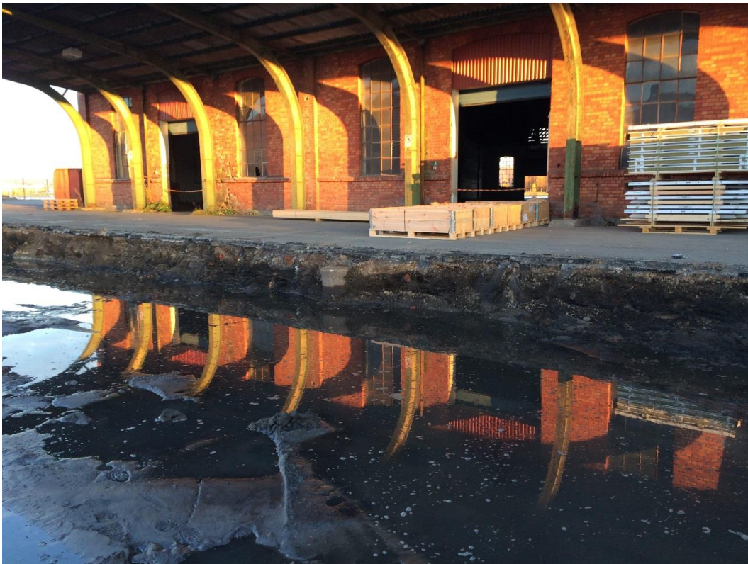
Dela av schaktvägg 13N-16N
