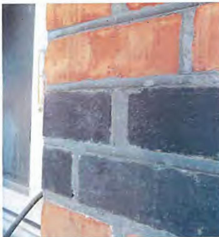
Detalj av tegelväggen med karakteristiskt engoberat tegel och åsfog.
