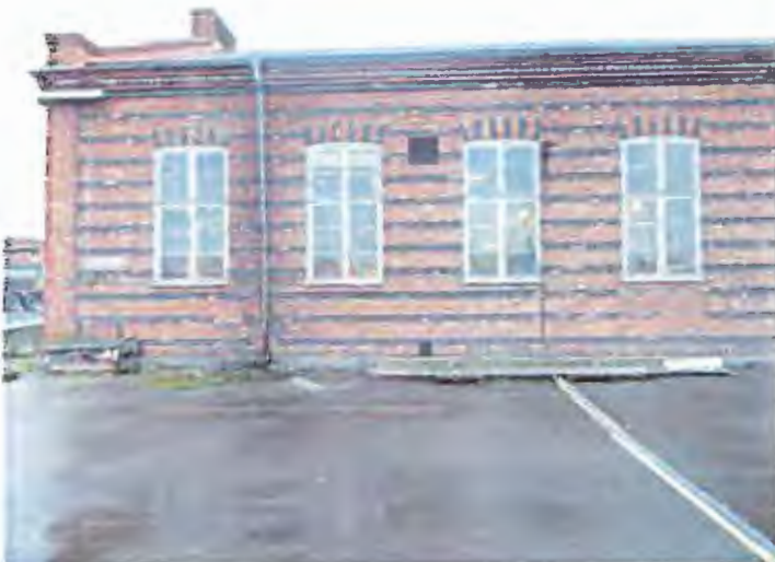
Parti av snickeriets fasad mot öster där man kan se spår efter en igenmurning under fönstret längst till höger.
