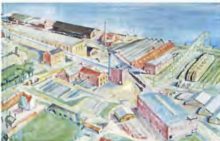
Målning från 1951 som i bildens mitt visar snickeriet och vägen med skorstenen. Målning av E. Wessel-Fougstedt.
