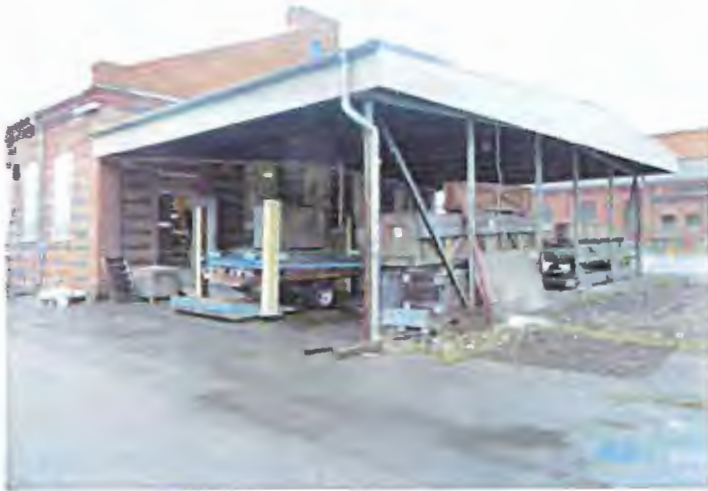
Det i sen tid tillbyggda skärmtaket.
