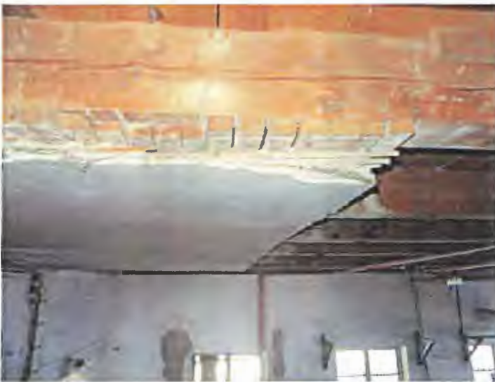
Detalj av ett bevarat parti av den konstruktion innetaket troligen hade från början.
