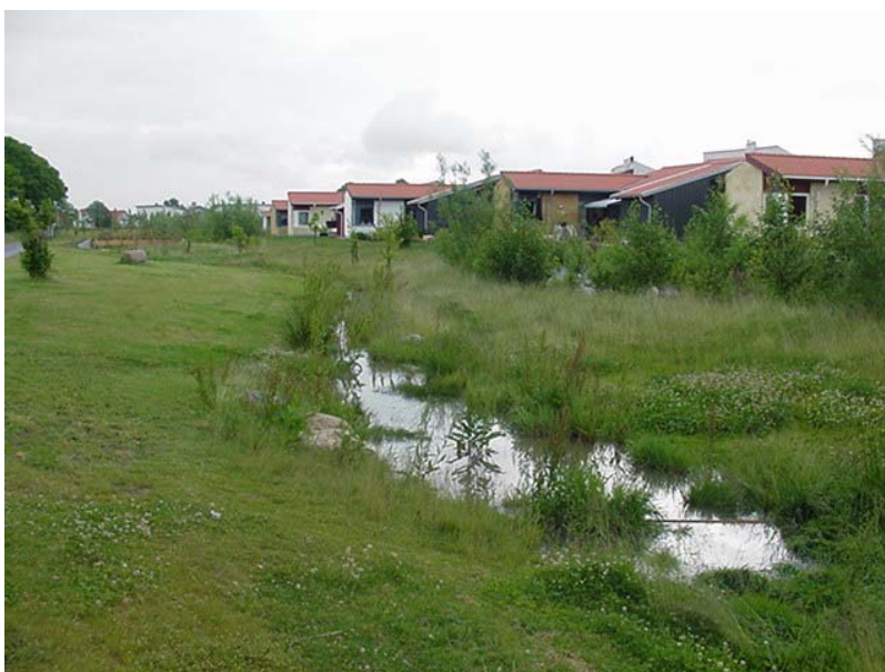
Bild 8. Dike och del av damm med stående vatten. Många dagvattenanläggningar från mindre områden med inget eller litet bakgrundsflöde växer tyvärr igen. Helsingborg (2002-06-11).
