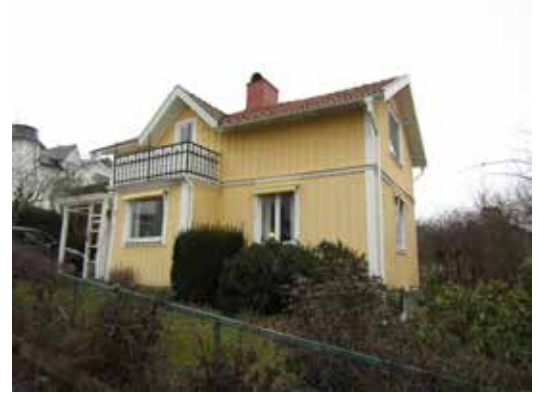
Tillbyggnaden och den ovanpåliggande balkongen tillkom sannolikt omkring 1960.
