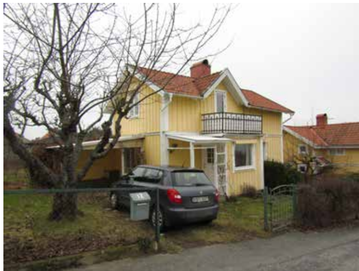
Bostadshuset på Tranan 12 präglas exteriört av en ombyggnad utförd omkring 1960.
