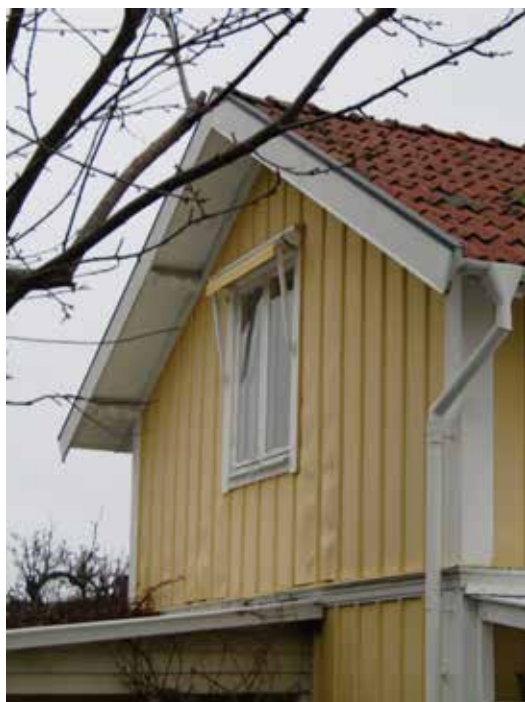
Fasaderna har vid något tillfälle försetts med en underliggande masonit med påspikade lister. Samtliga fönster är utbytta och vindskivorna är plåtinklädda. De dekorativa taktassarna och den profilerade midjebandslisten på fasaden utgör dock äldre, bevarandevärda byggnadsdetaljer.
