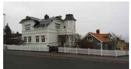
De två bostadshusen på Tranan 8 är uppförda kring sekelskiftet 1900.
