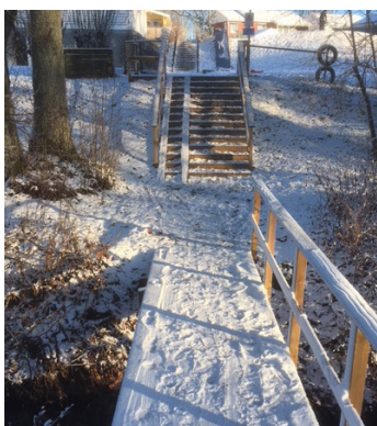
Foto, gångbro och trappa Hisingstorp
