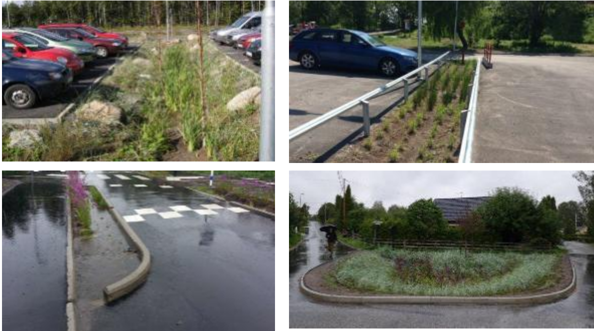
Figur 7: Uppe t v: Raingarden vid pendlarparkeringen Campus Roslagen i Norrtälje, källa: Veg Tech AB. Uppe t h: Raingarden i Portland USA. Nere t v: Raingarden vid Öringevägen i Tyresö kommun, källa: WSP. Nere t h: Raingarden vid Åkervägen Tyresö. Källa WSP.
