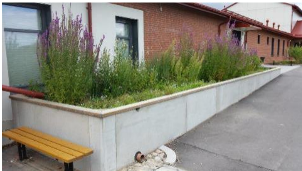
Figur 14: Stuprör från byggnad kopplade till en växtbädd i Lund. WSP 2015.
