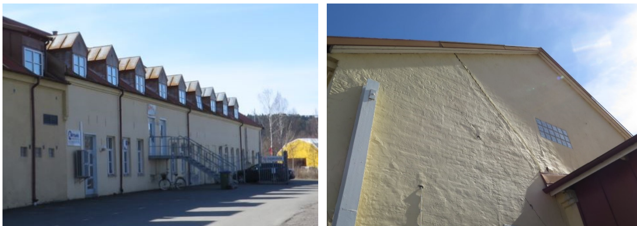
Figur 3-2. Österbotten 4, Atkins foto från platsbesök 2015-04-08
