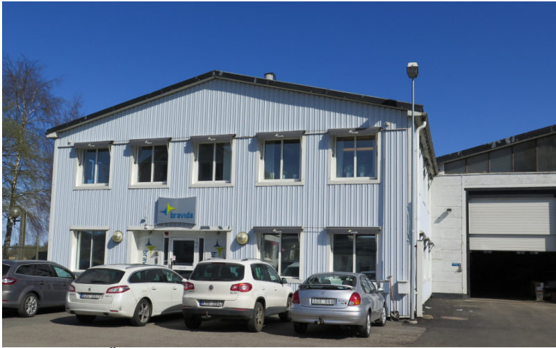
Figur 6-2. Övergången 9, Atkins foto från platsbesök 2015-04-08
