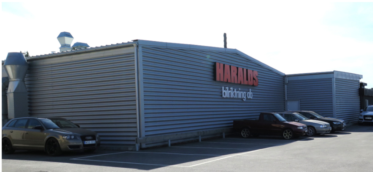
Figur 9-2. Övertiden 1, Atkins foto från platsbesök 2015-04-08
