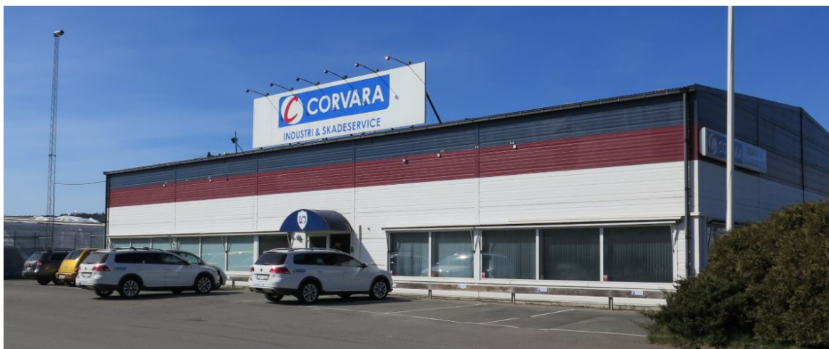
Figur 6-6. Övergången 9, Atkins foto från platsbesök 2015-04-08
