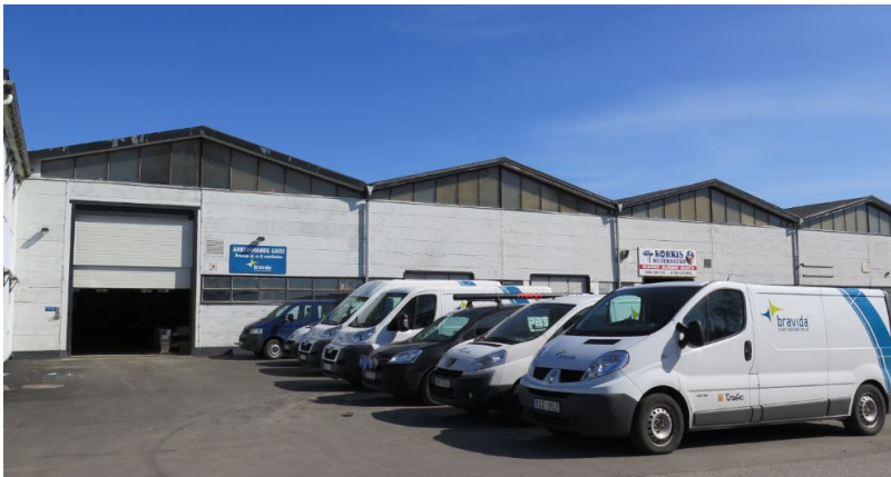
Figur 6-3. Övergången 9, Atkins foto från platsbesök 2015-04-08
