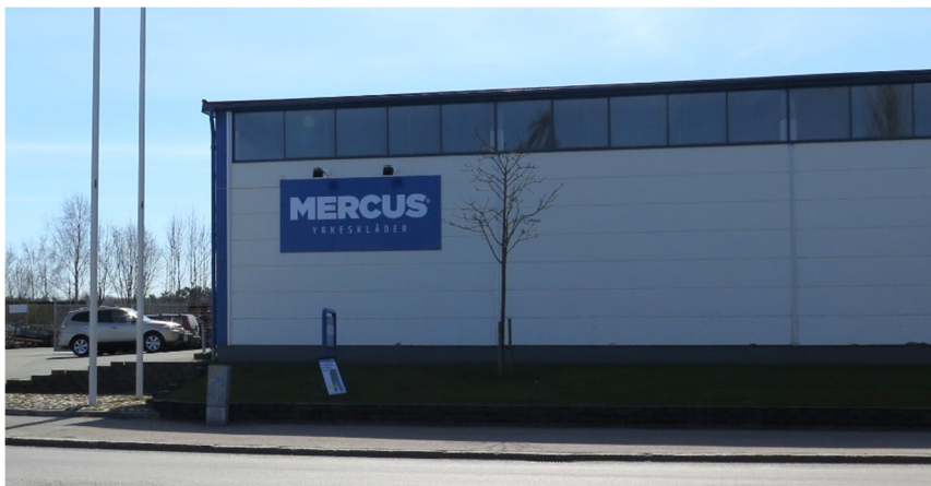
Figur 7-3. Örtugen 3, Atkins foto från platsbesök 2015-04-08
