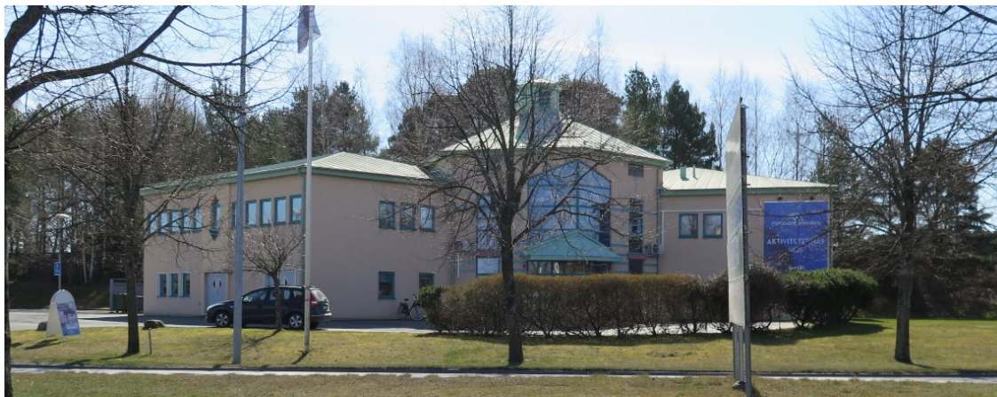
Figur 7-2. Örtugen 3, Atkins foto från platsbesök 2015-04-08
