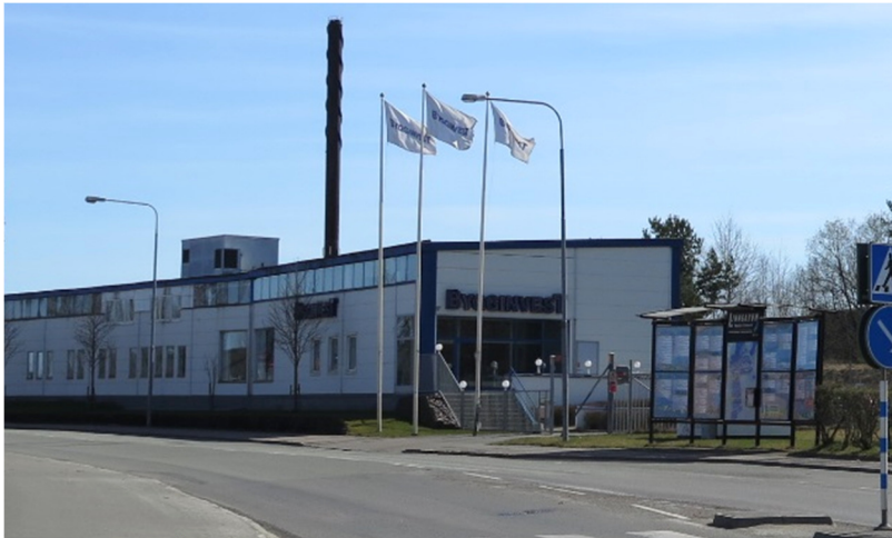
Figur 7-5. Örtugen 3, Atkins foto från platsbesök 2015-04-08
