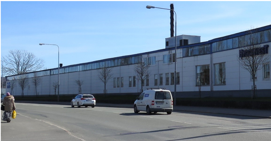
Figur 7-4. Örtugen 3, Atkins foto från platsbesök 2015-04-08
