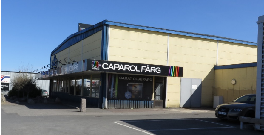
Figur 9-3. Övertiden 2, Atkins foto från platsbesök 2015-04-08
