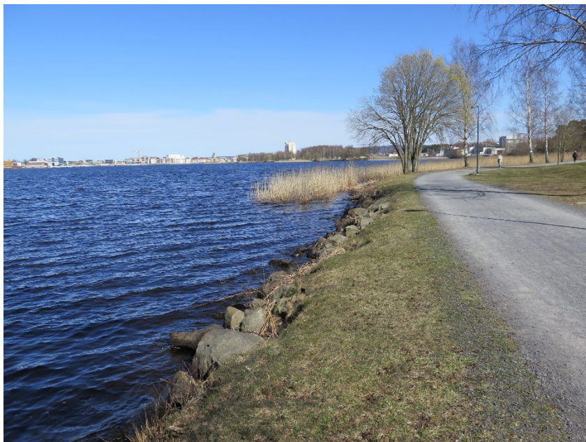
Figur 6-1. Gång- cykelväg utmed Munksjöns strand. Strandslänterna är relativt flacka och är delvis klädda med erosionsskydd. Foto Atkins 2015-04-08
