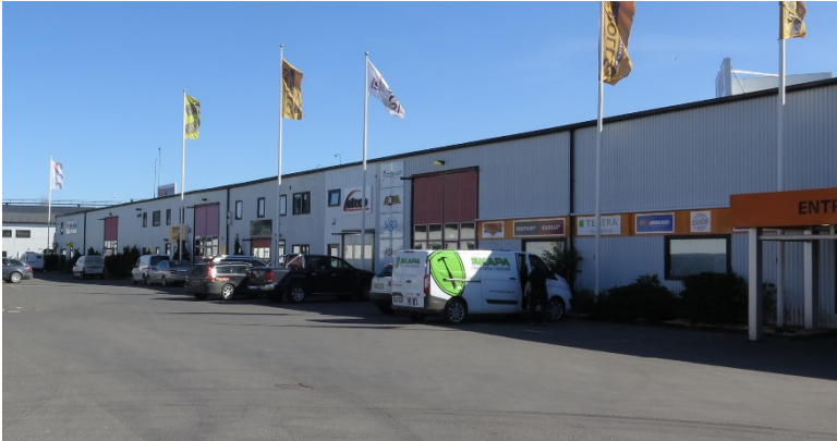
Figur 9-6. Övertiden 6, Atkins foto från platsbesök 2015-04-08
