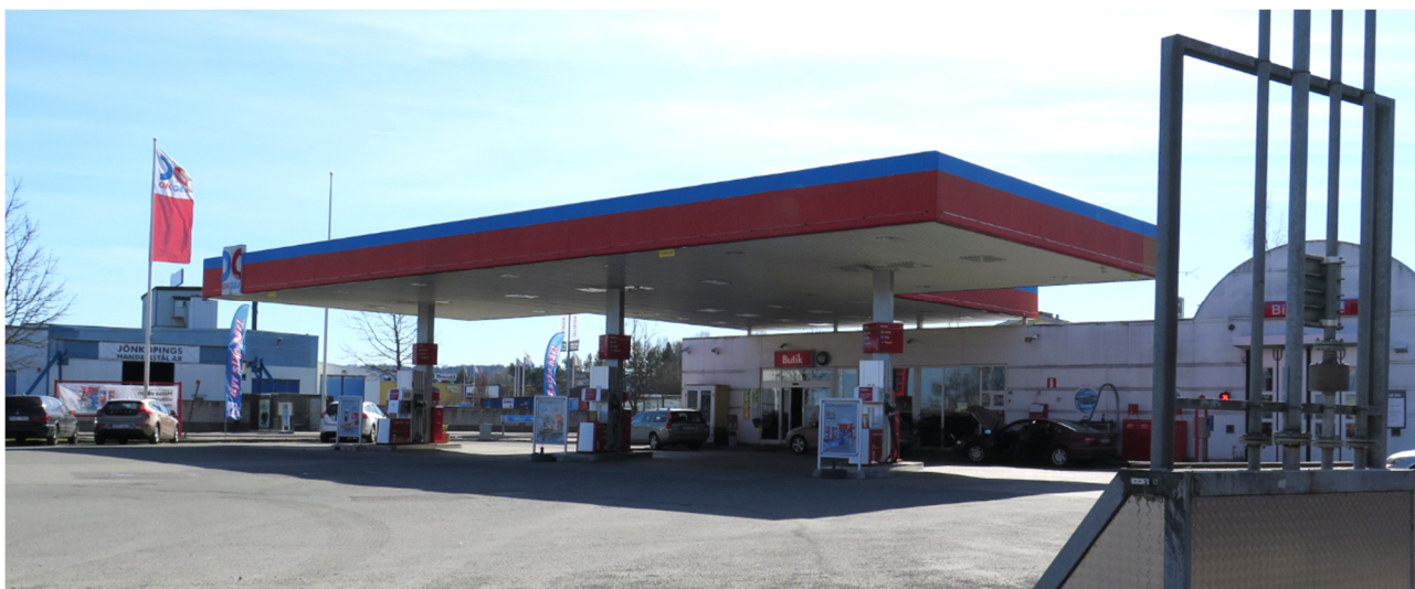
Figur 1-3. Öringen 11, Atkins foto från platsbesök 2015-04-08
