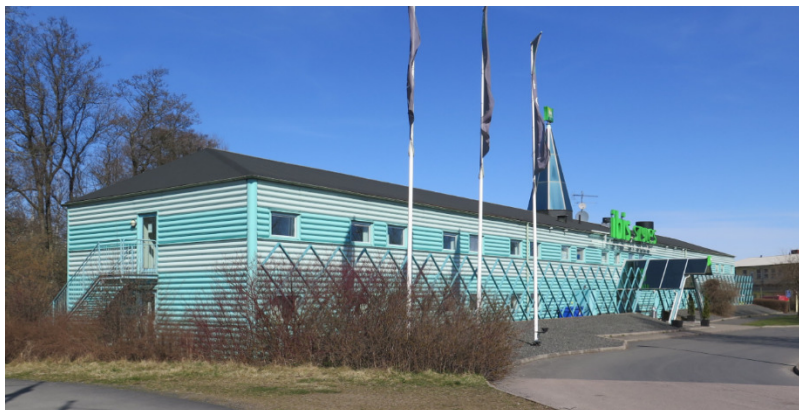
Figur 1-4. Öringen 12, Atkins foto från platsbesök 2015-04-08
