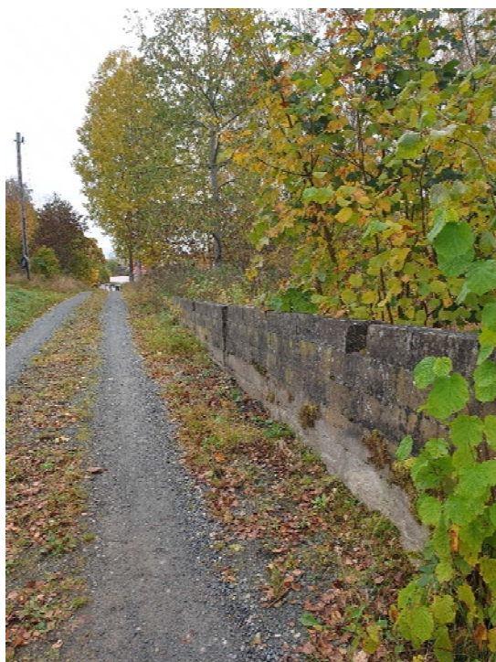
Figur 3 Rester av grund till f.d. växthus.
