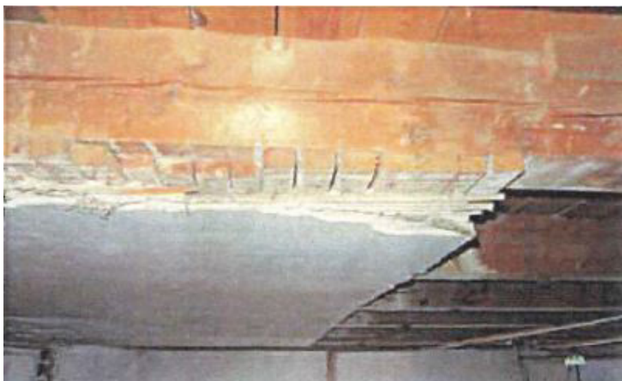
Interiör detalj av ett bevarat parti med den konstruktion innertaket troligen hade från början
