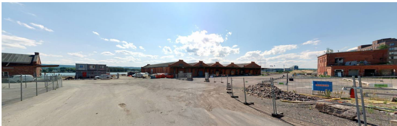
Delar av exploateringsområdet vid Munksjöstaden där Säckfabriken, Panncentralen och Snickeriet finns bevarade .
