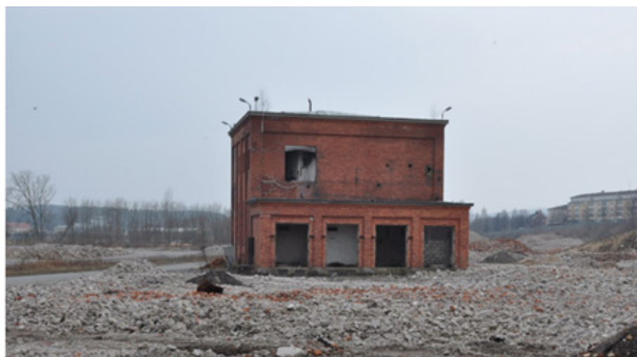
Exteriört av Panncentralens norra fasad där den lägre rektangulära byggnadskroppen, Ställverket ansluter.
