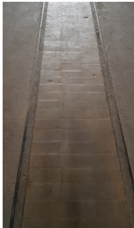
Detalj av det gjutna golvet i Säckfabriken och spårdragningar för 750 mm smal järnväg som tidigare användes för frakt inom området.
