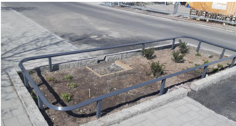
Figur 13. Regnbädd med släppunkt genom öppen kantsten (Tyréns AB, 2020)
