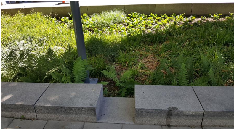
Figur 12. Nedsänkt regnbädd med släppunkt genom öppen kantsten (Tyréns AB, 2020)
