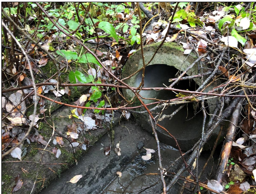
Figur 11. Utlopp för närliggande dagvattennät.
