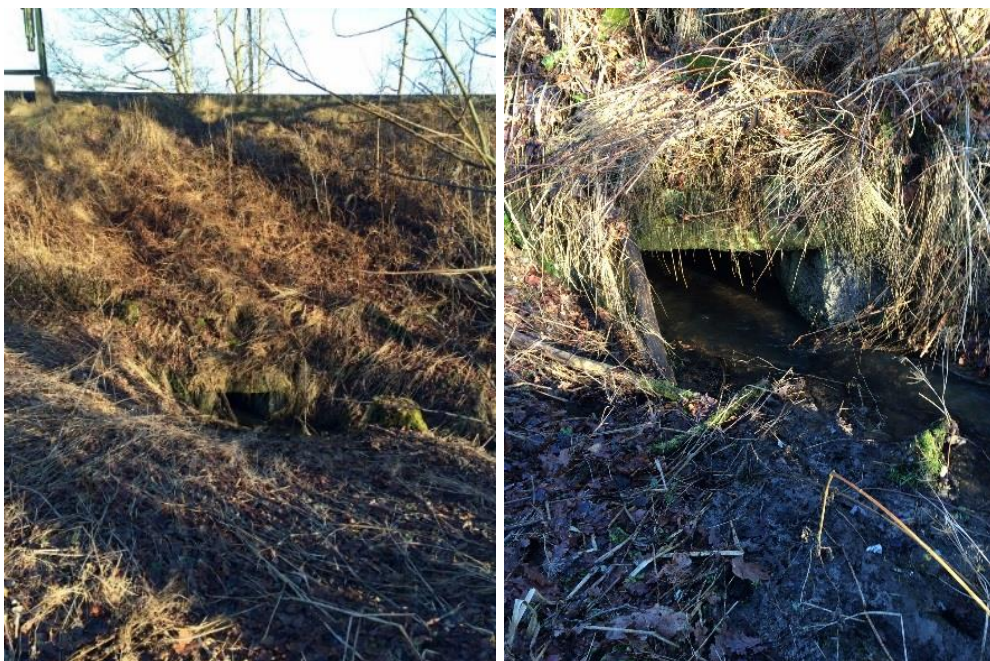
Figur 10. Fotografier av inlopp till kulvert 2 på västra sidan om järnvägen.
