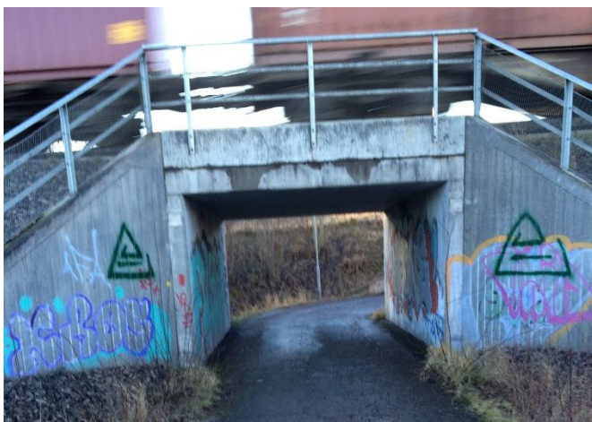
Figur 12. Befintlig GC-tunnel under järnvägen.
