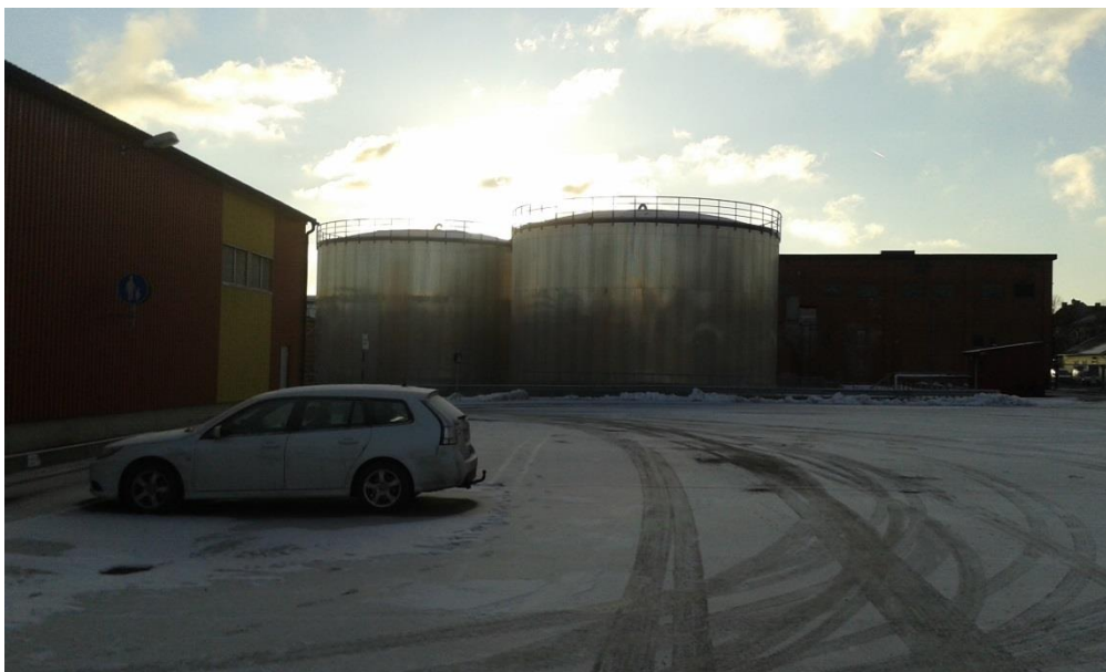
Figur 10. Jönköpings Energis cisterner i verksamhetsområdet norr om Bygatan.
