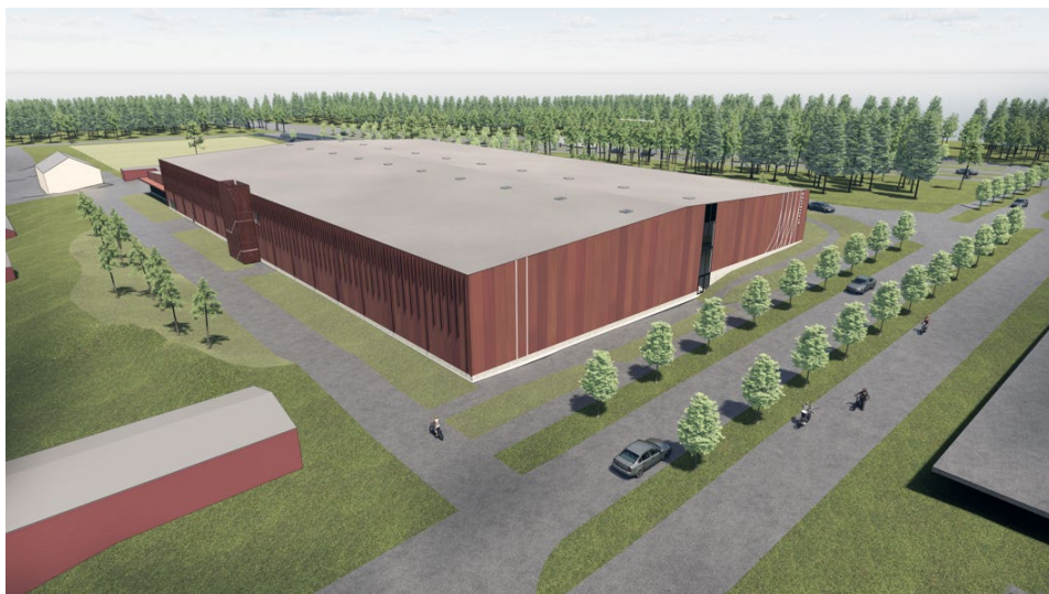
Vy över friidrottshallen från söder (Krook och Tjäder).
