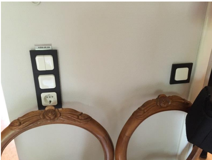
Kontrast färgat väggskydd runt lysknappar och eluttag.
