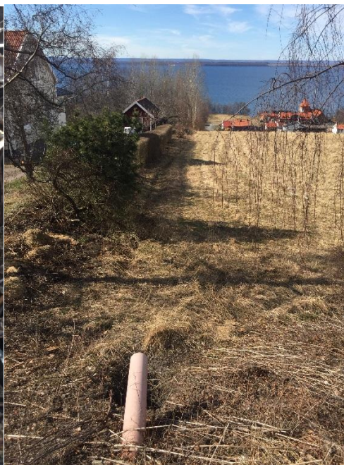
Figur 13 Utlopp från väggavvattning, Jönköpingsvägen
