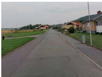
Figur 32 och 33 På den vänstra bilden syns Jönköpingsvägen. På den högra bilden syns Skiftesvägen.
