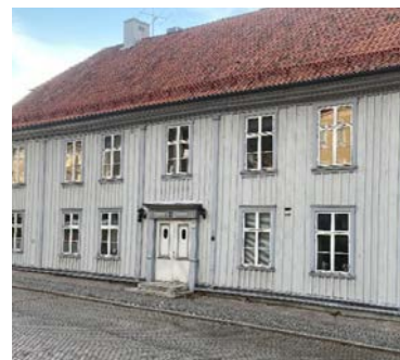
Figur 52 Stående fönsterpartier med spröjs.
