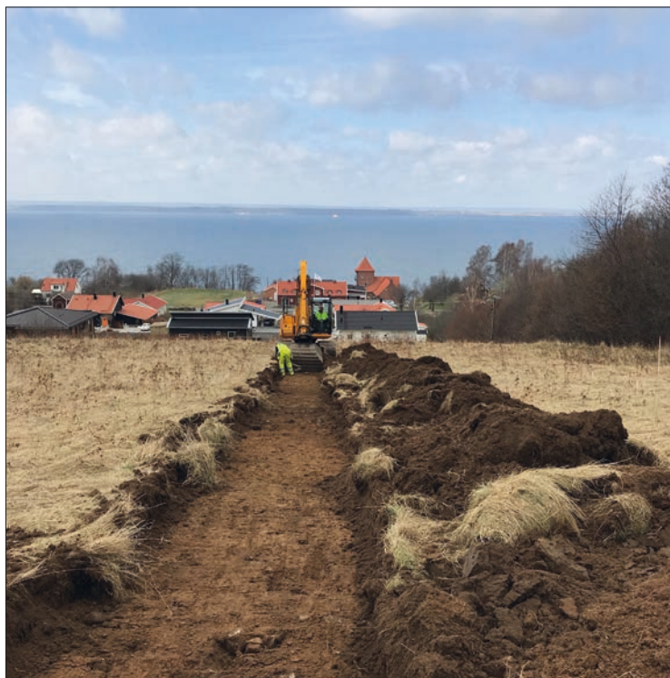
Figur 17. Sökschaktning i området där flest anläggningar påträffades, i området söder om vattentuben.
